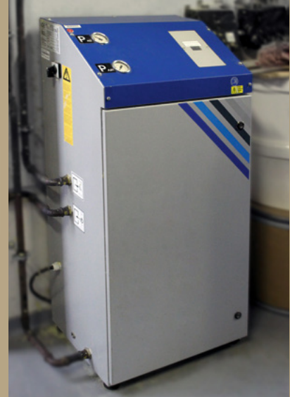
Nitrogen generator at Fraunhofer UMSICHT, photo: Silvia Lorenz
