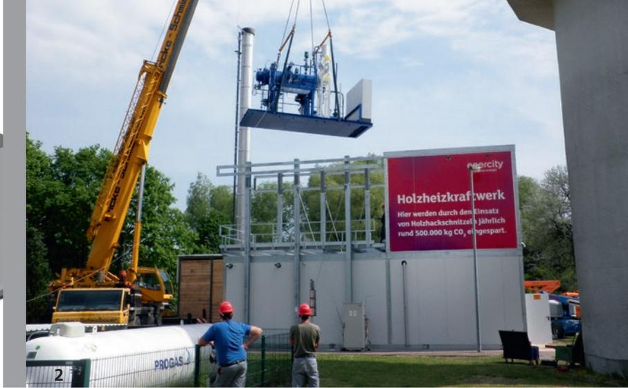
1 ORC-Modul mit Schnittstelle zu einem konventionellen Wasser-Dampf-Kreislauf.
